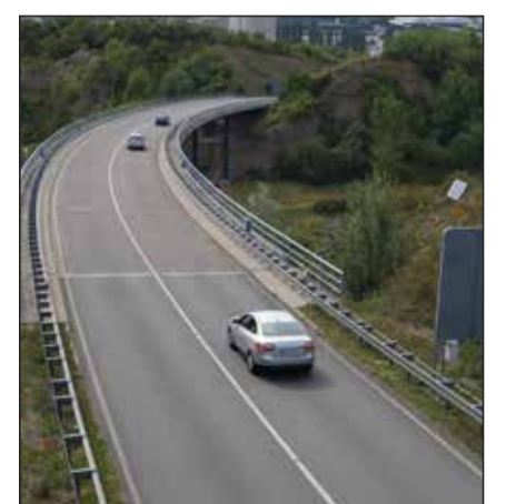
Deutliche Verkehrsentslastung des Stadtkerns durch die neue Nordostumgehung
